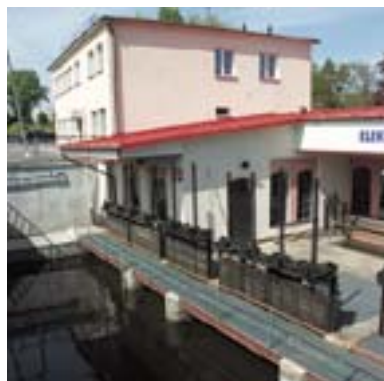
Płoty – elektrownia wodna
